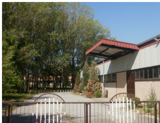
Сл.32 складишни простор, спољни изглед
