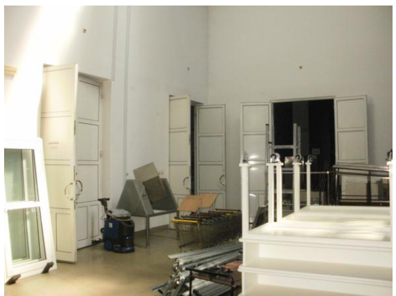
Сл.30 складишни простор, унутрашњи изглед
