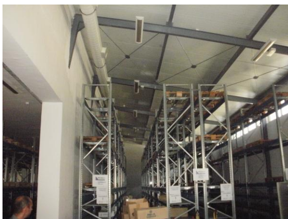
Сл.41 складишни простор, унутрашњи изглед
