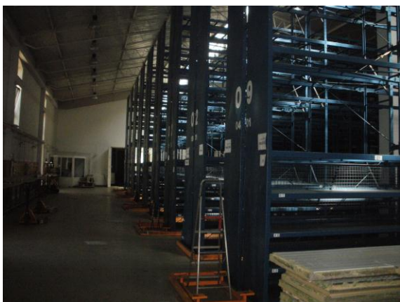
Сл.29 складишни простор, унутрашњи изглед
