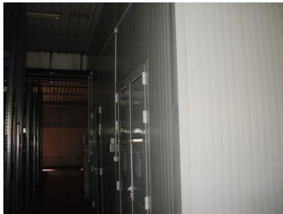
Сл.36 складишни простор, унутрашњи изглед
