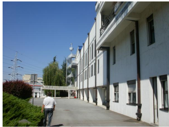
Сл.2 складишни простор, спољни изглед
