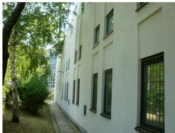
Сл.44 складишни простор, спољни изглед
