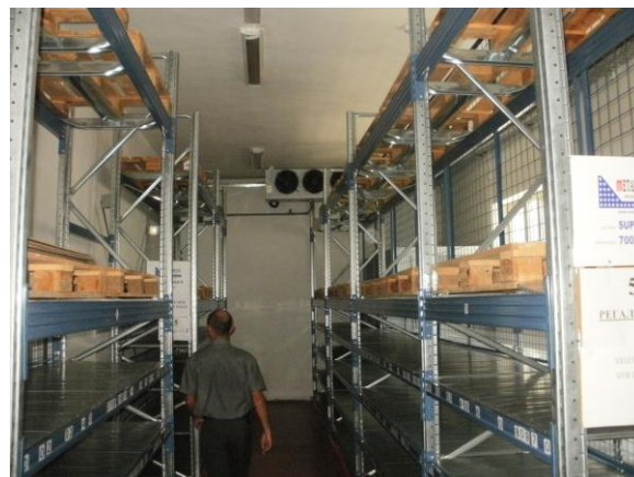
Сл.42 складишни простор, унутрашњи изглед
