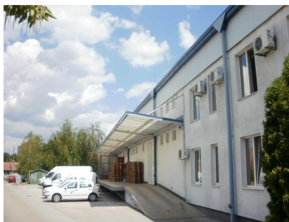
Сл.20 складишни простор, спољни изглед
