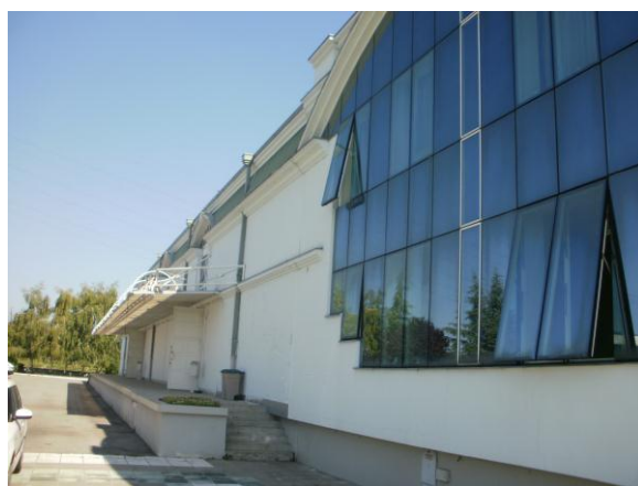
Сл.26 складишни простор, спољни изглед
