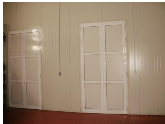
Сл.48 складишни простор, унутрашњи изглед
