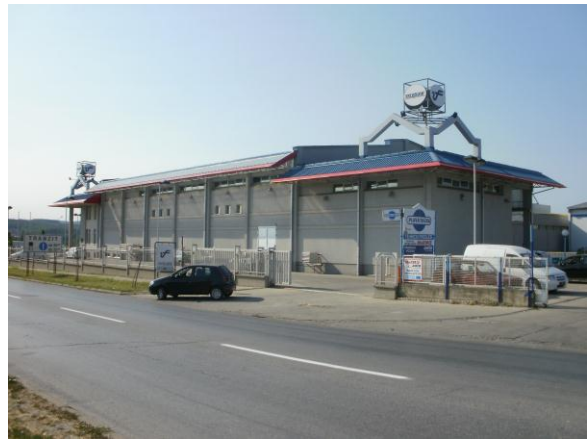
Сл.14 складишни простор, спољни изглед
