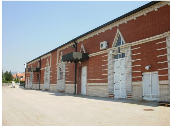
Сл.8 складишни простор, спољни изглед
