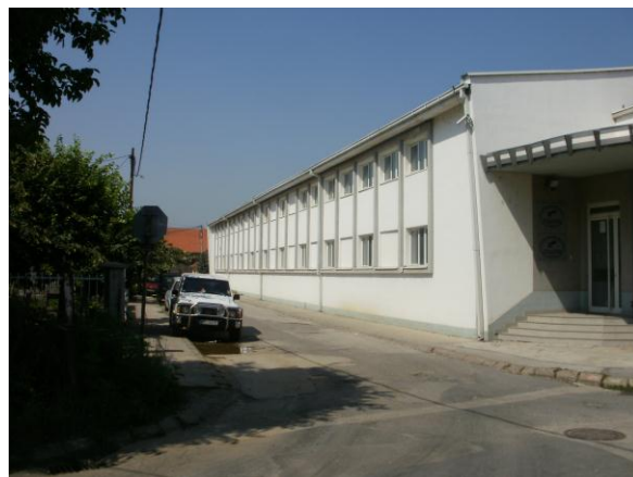
Сл.38 складишни простор, спољни изглед
